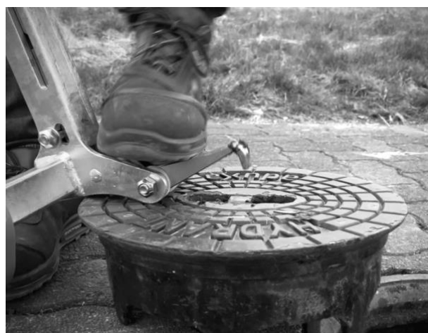
6. Haken wird abschließend per Fuß ausgeklinkt.
