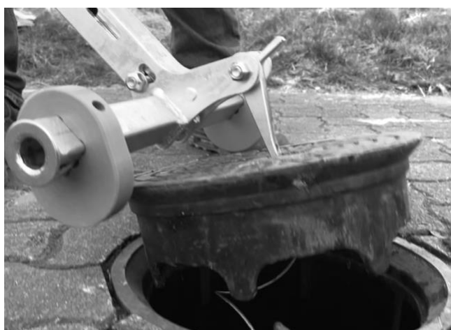
5. ... ausgehoben und zur Seite geschwenkt werden.
